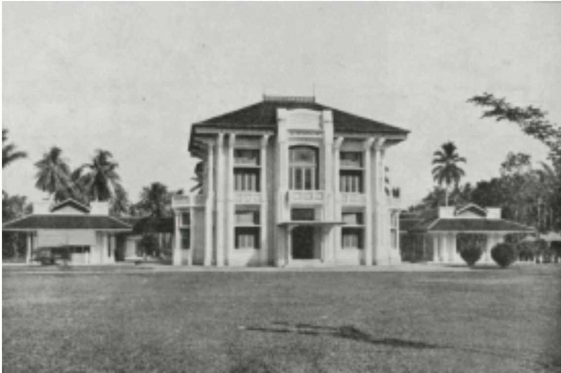
Gambar 6. Gedung stasiun uji AVROS., Sumber : T. Volker, Van Oerbosch tot Cultuurgebid , 1928: 60.
