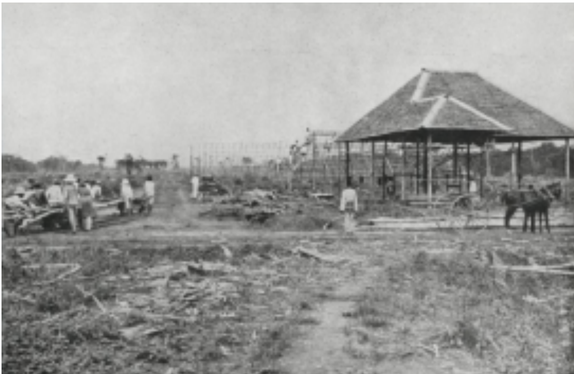
Gambar 10. Proses pembangunan bangsal pengeringan di emplasemen perkebunan., Sumber: T. Volker, Van Oerbosch tot Cultuurgebid , 1928: 14.
