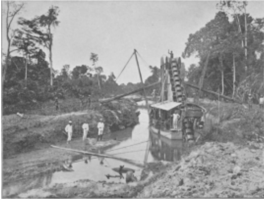
Gambar 3. Penggunaan mesin keruk untuk pembangunan kanal., Sumber: T. Volker, Van Oerbosch tot Cultuurgebied , 1928: 92
